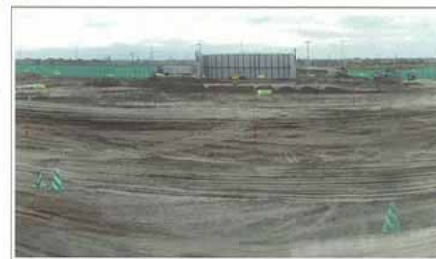
■施工写真 (着工より5ヶ月経過)
