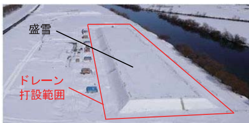
写真-1 盛雪完了後全景
