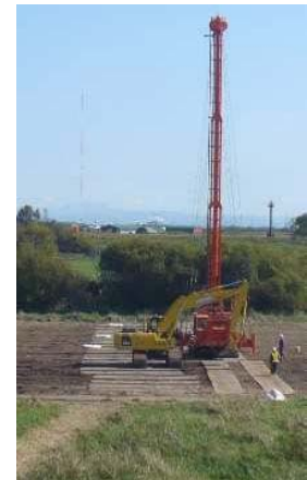
写真2 ドレーン打設状況
